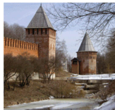
Громовая башня и башня Бублейка
